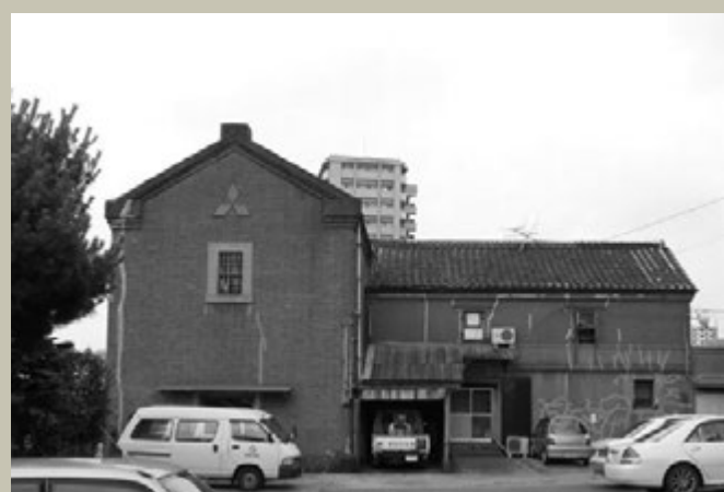
三菱合資会社の面影を残す敷地内の煉瓦造り倉庫
